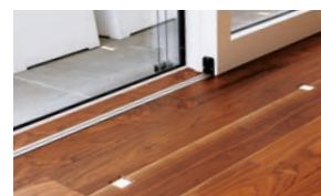
Klizna vodilica niskog alu prağa neprimjetno ugrađena u pod.
